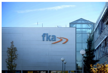
Hauptsitz der fka GmbH in Aachen
